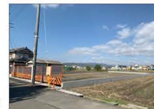
造成工事完了後の現場の様子⇒
